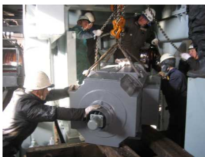
(原動機解体整備)
