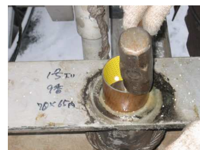
(支柱ビームメタル交換)
