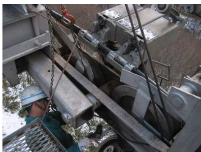
(支柱受索装置の交換)
