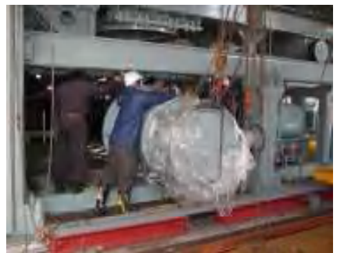
主減速機交換作業
